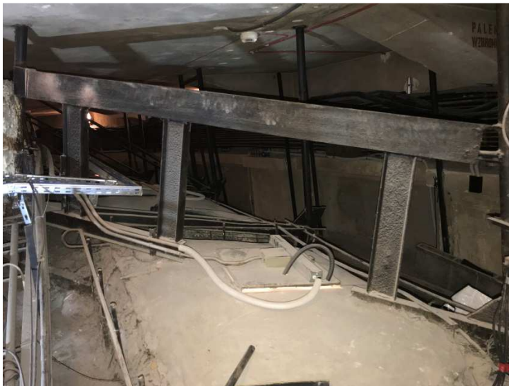
Fot. 3 – Konstrukcja plafonu – element narożny
