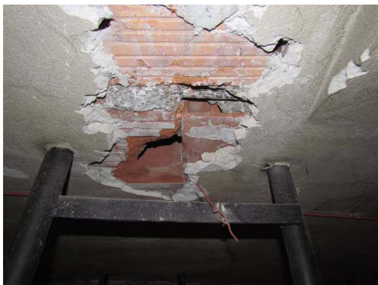
Fot. 14 - Odkrywka zbrojenia stropu Akermana
