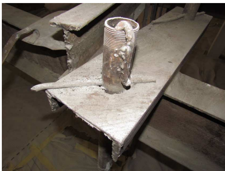
Fot. 24 – Mocowanie wieszaka z rury do konstrukcji stalowej od strony poddasza
