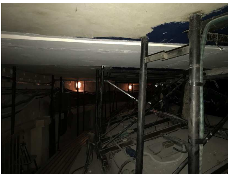
Fot. 19 – Zabezpieczenie p.poż. stropu Akermana przy dawnym otworze
