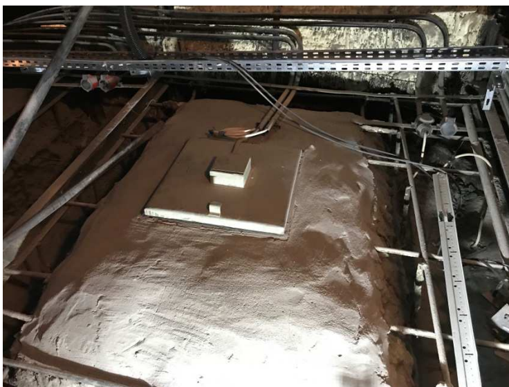
Fot. 4 – Konstrukcja kasetonu od góry
