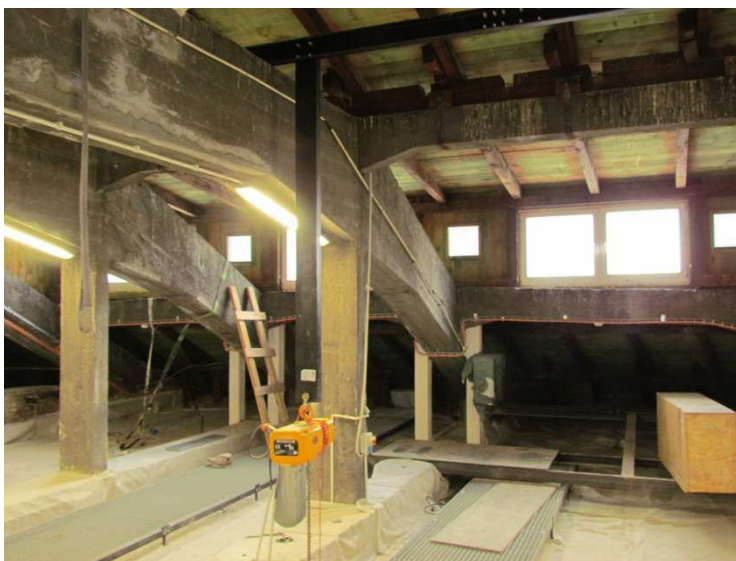
Fot. 21 - Konstrukcja żelbetowa dachu
