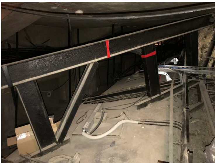
Fot. 9 – Konstrukcja plafonu – element narożny
