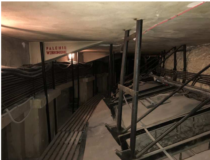
Fot. 7 - trakt boczny, widać wycięte zastrzały
