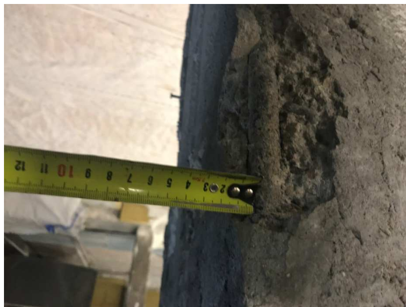
Fot. 29 – Odkrywka zbrojenia oraz grubości otulenia w wieszaku dźwigara żelbetowego
