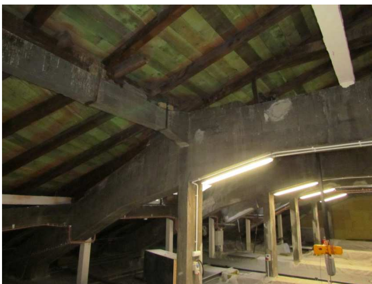
Fot. 22 - Węzeł typowego dźwigara
