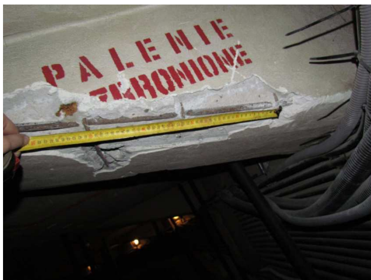
Fot. 18 – Odkrywka pasa dolnego dźwigara żelbetowego
