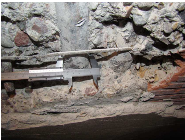
Fot. 16 – Pomiar średnicy zbrojenia pasa dolnego dźwigara od dołu
