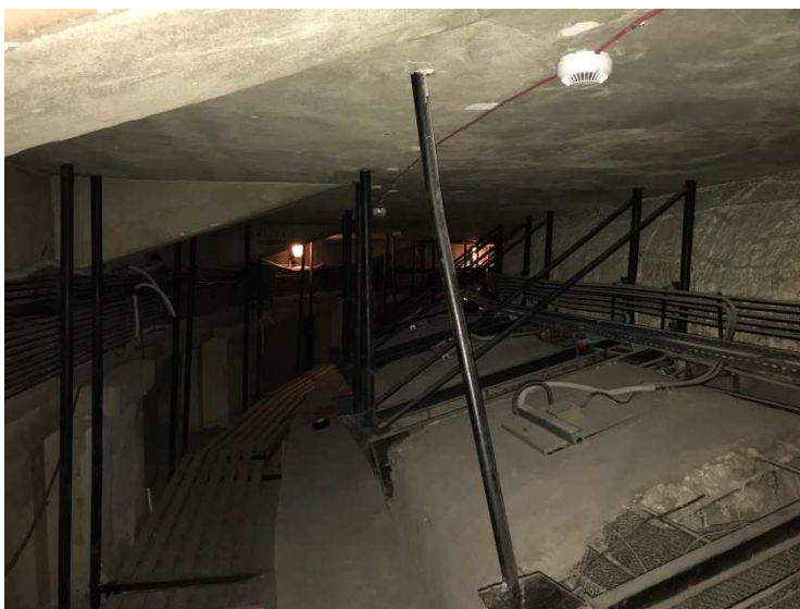
Fot. 8 - Układ prętowy podwieszenia plafonu – trakt boczny
