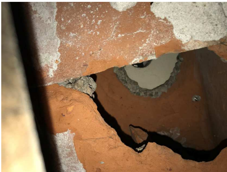
Fot. 11 - Odkrywka stropu Akermana
