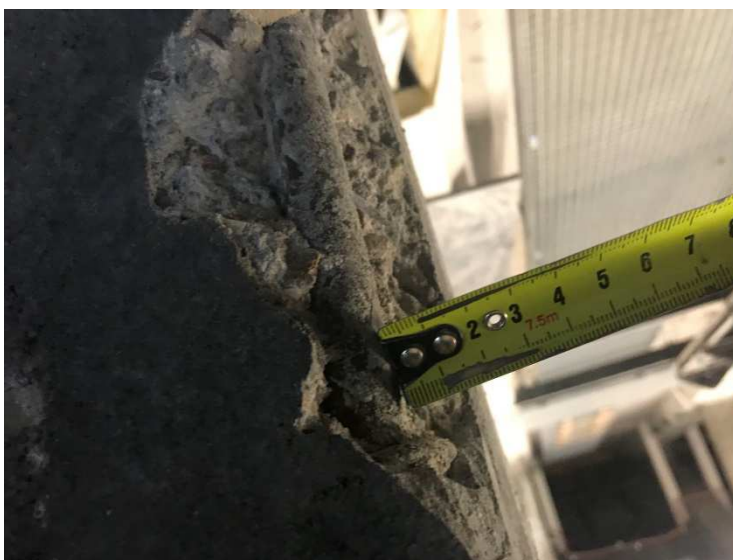
Fot. 28 - Odkrywka zbrojenia oraz grubości otulenia w wieszaku dźwigara żelbetowego
